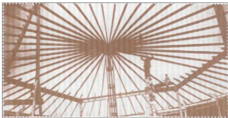
Монтаж покрытия резервуара большого диаметра. 1900-е гг.
