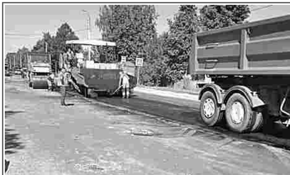
В 2022 году отремонтировано около 8 км дорог в городе и районе
