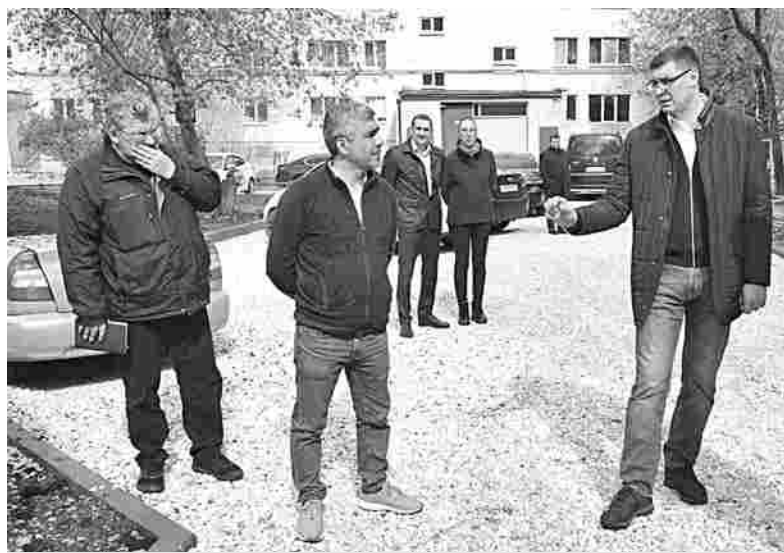
Проверка работ по устройству дорожного покрытия в г.Владимире
