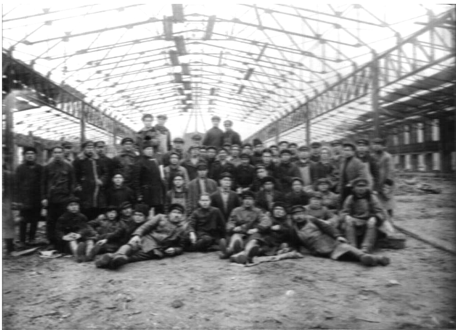
1926г. Строительство Бахметьевского автобусного гаража. Котельщики на фоне металлоконструкций
